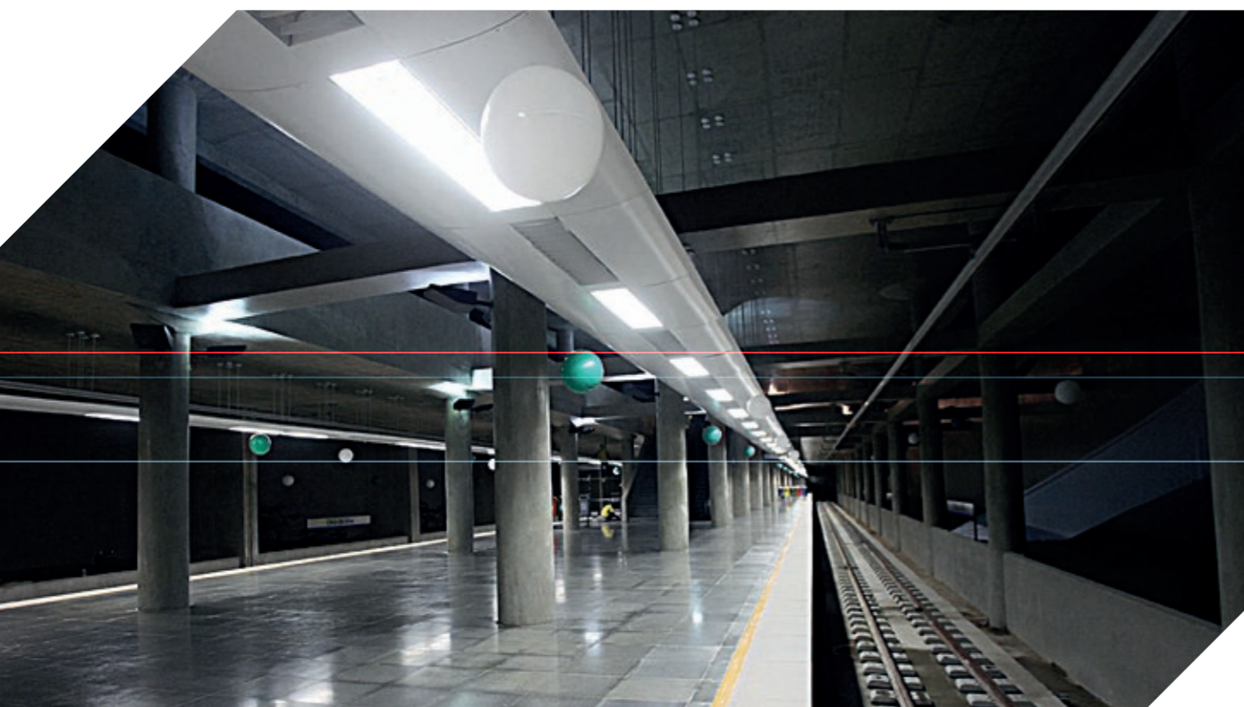
ESTAÇÃO CHICO DA SILVA – METRÔ DE FORTALEZA/CE – LINHA SUL
