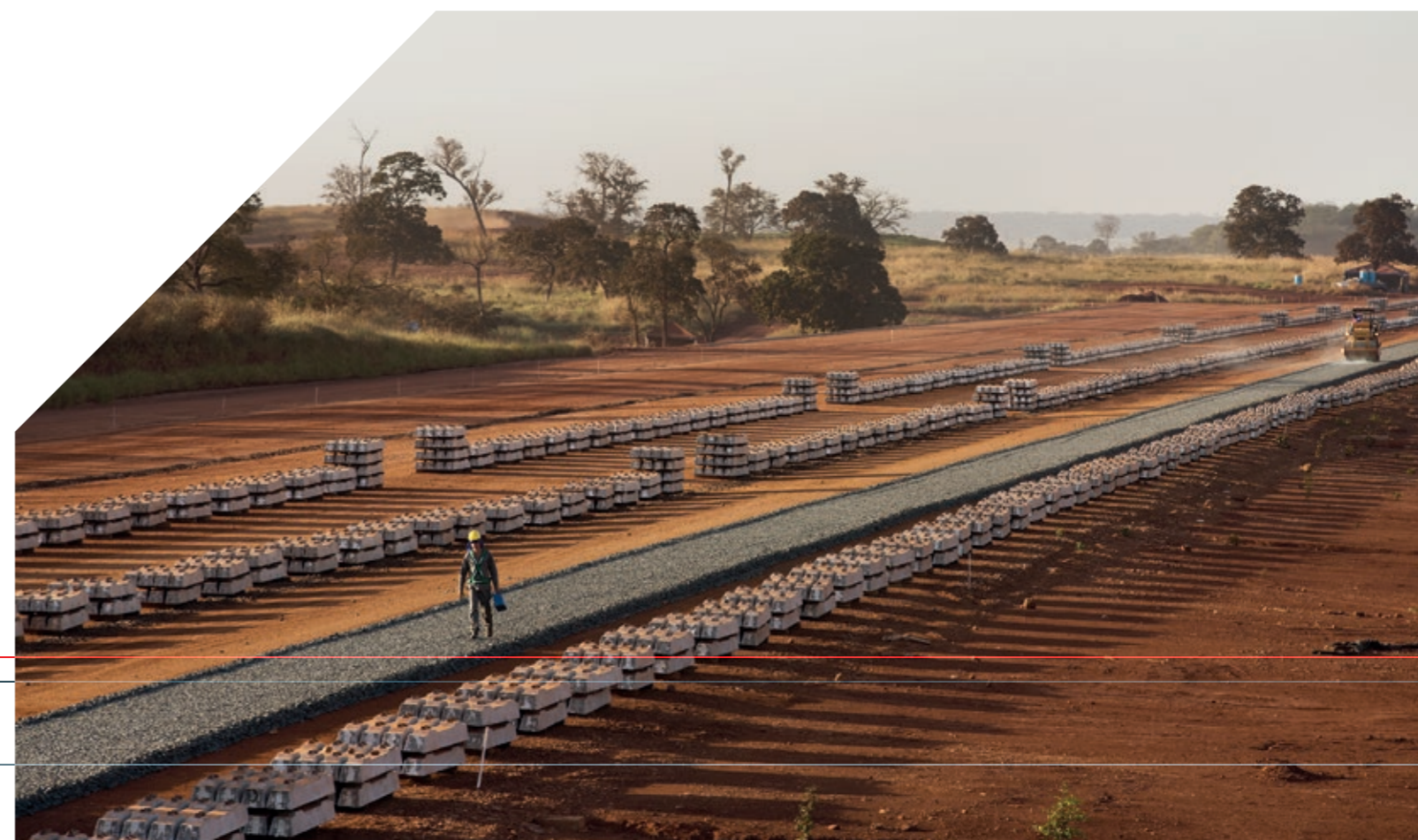
FERROVIA NORTE SUL - LOTE 4 - SÃO SIMÃO/GO
