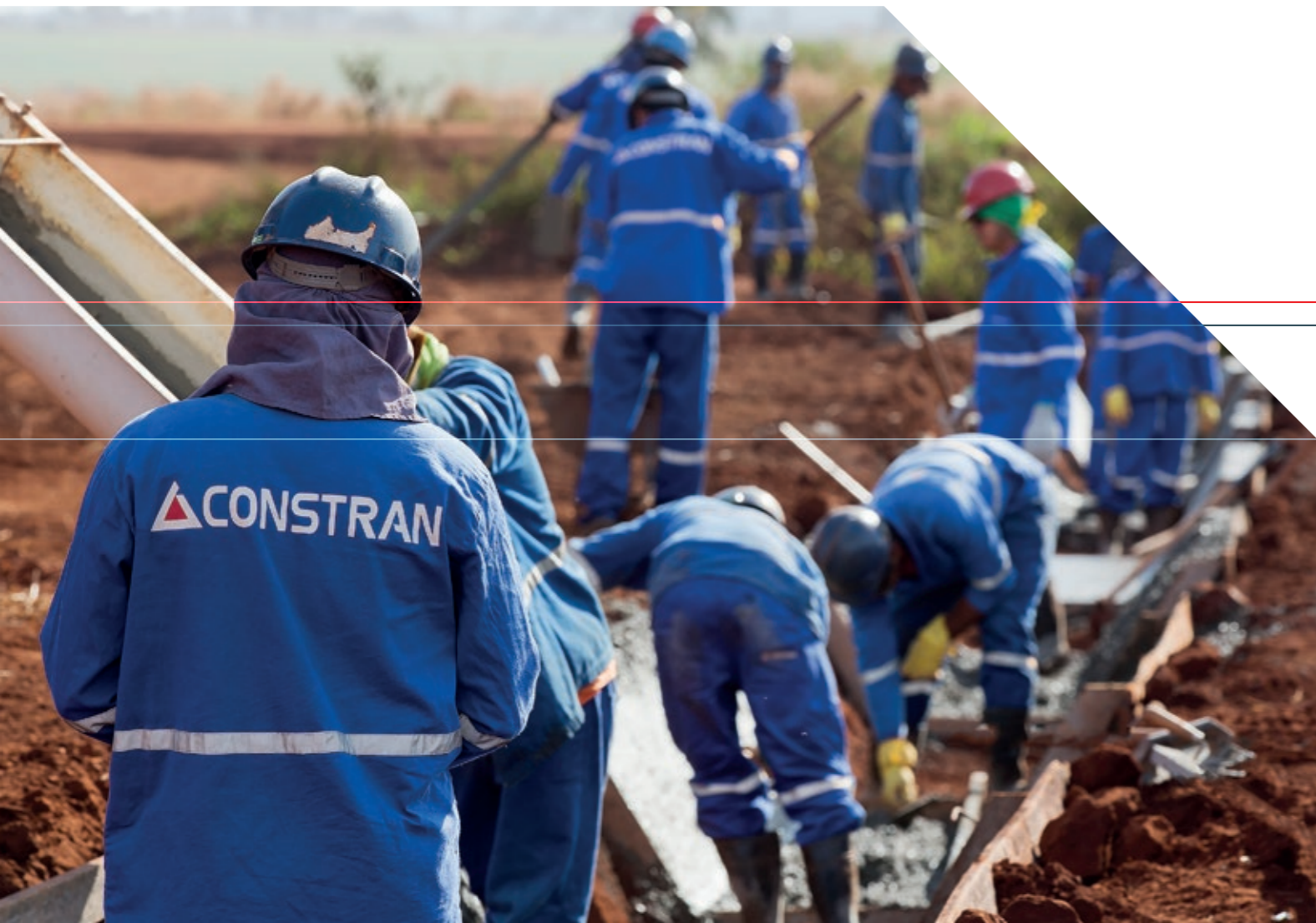
FERROVIA NORTE SUL - LOTE 4 - SÃO SIMÃO/GO
