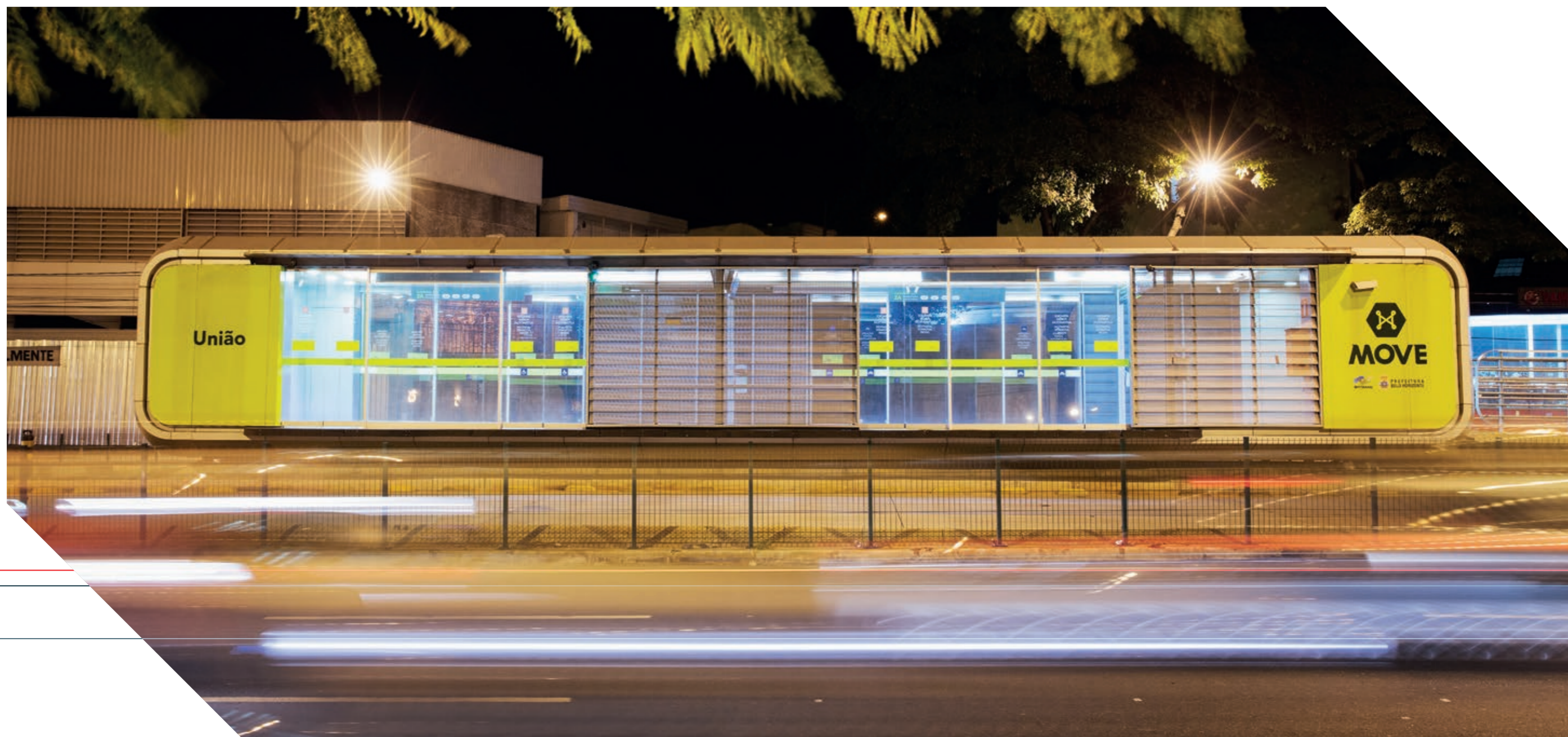
ESTAÇÃO DE TRANSFERÊNCIA DE PASSAGEIROS NOS CORREDORES DE TRANSPORTE DO SISTEMA BRT - BELO HORIZONTE/MG
