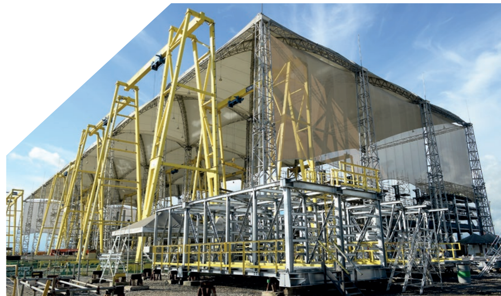
CONSÓRCIO PIPE RACK - COMPERJ - ITABORAÍ, RJ
