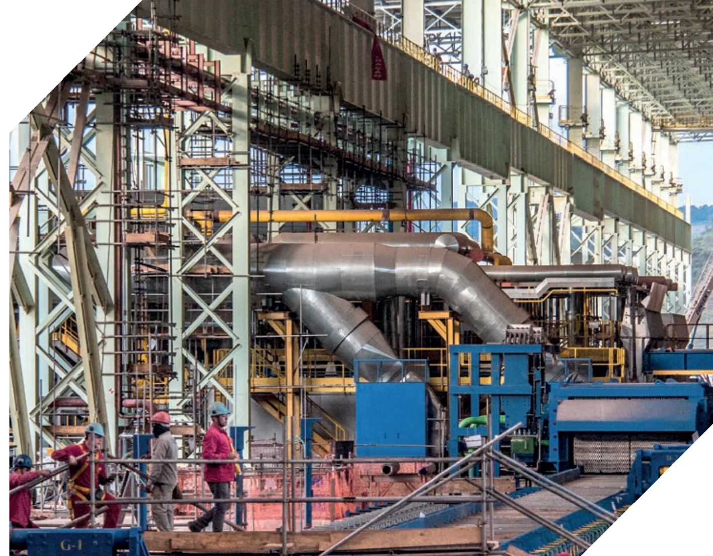
LAMINAÇÃO DE PLANOS - GERDAU AÇOMINAS - MG
