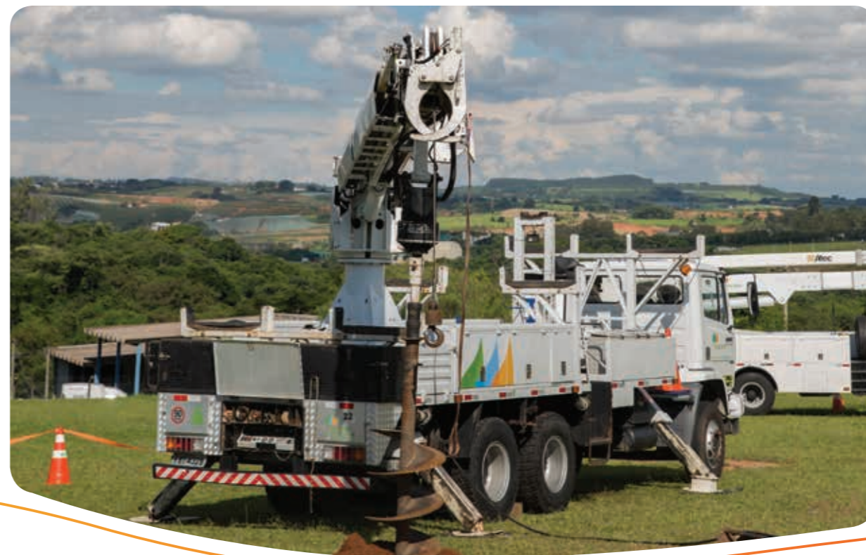
Digger Derick em operação
