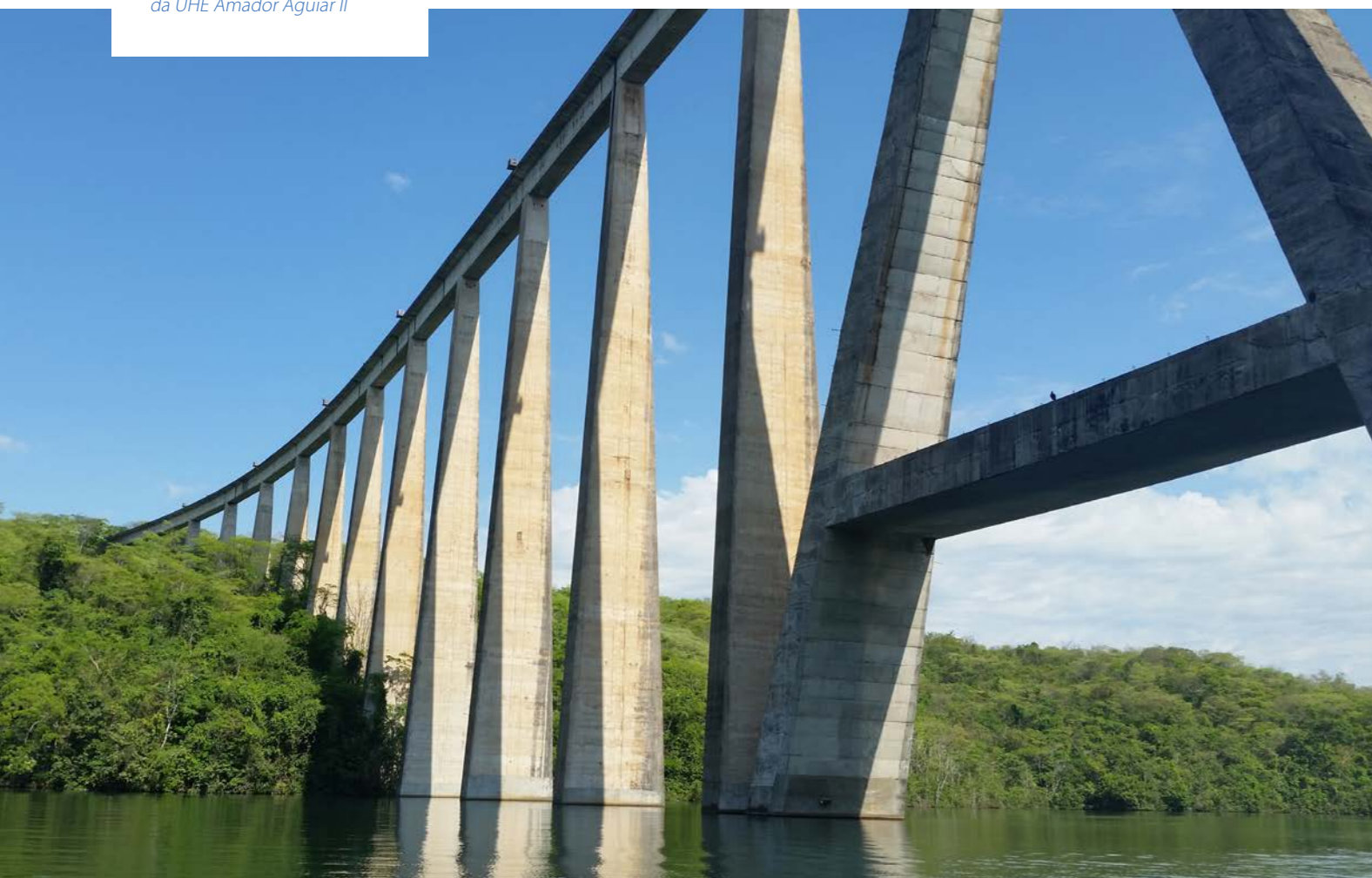
Pontilhão sobre o reservatório da UHE Amador Aguiar II
