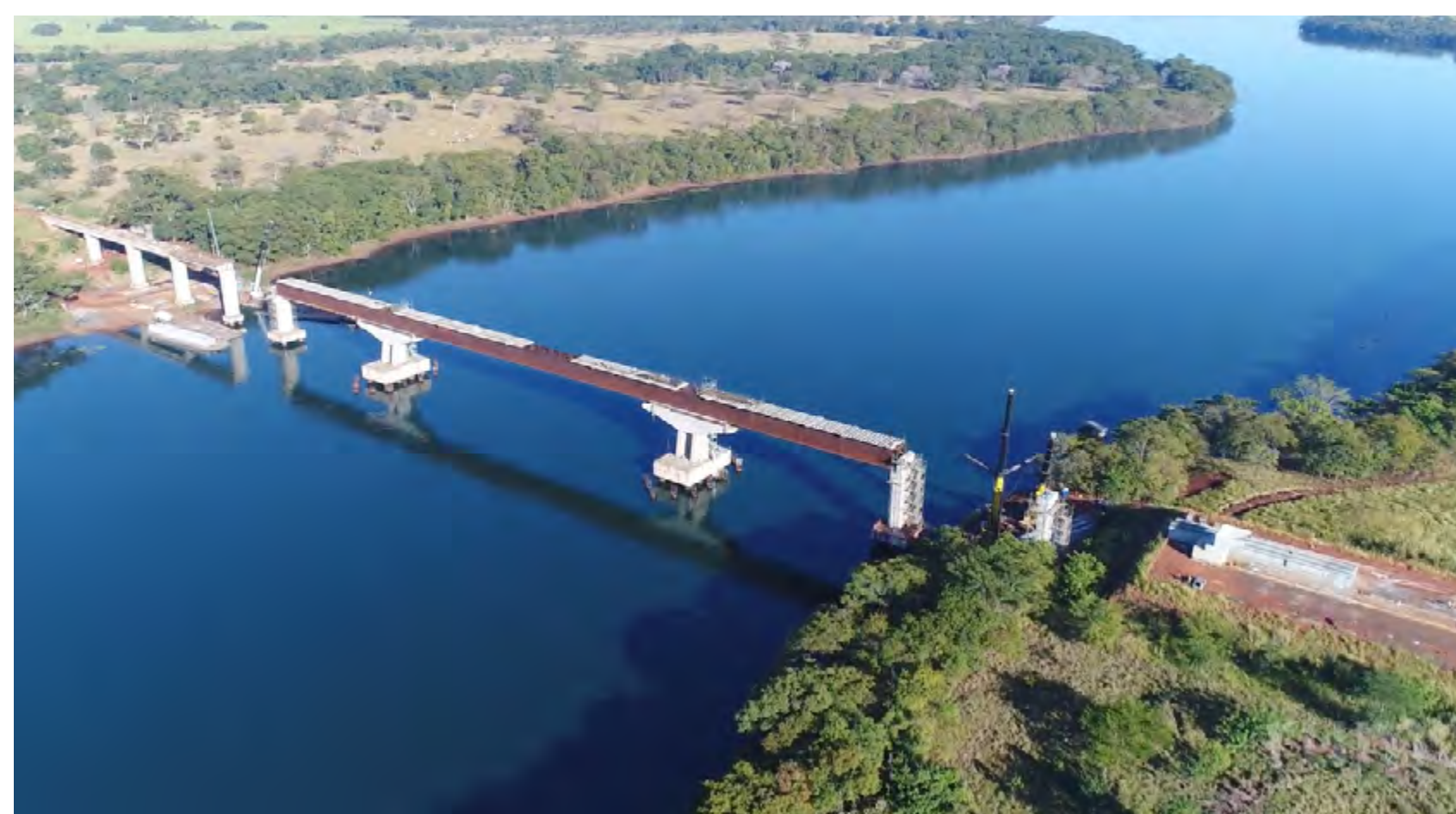
Ponte sobre o Rio Grande, na divisa entre os estados de Minas Gerais (Iturama) e São Paulo (Ouroeste).
