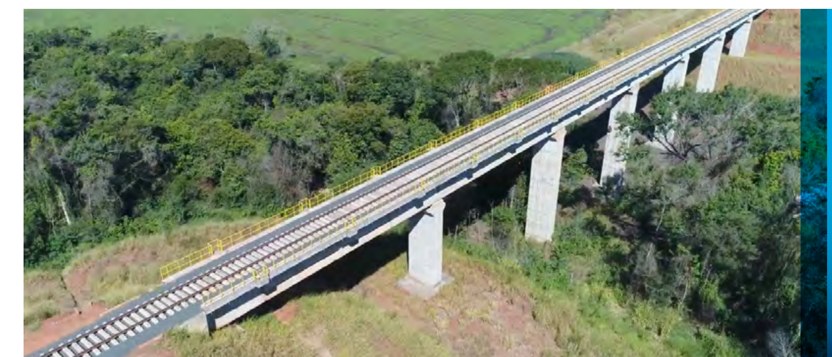
Ponte sobre Rio Mateira (Paranaiguara/GO).
