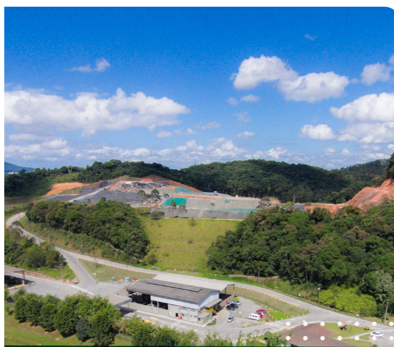
Cobertura em Aterro Sanitário para impermeabilização do solo na UVS Essencis Catarinense - Joinville - SC
