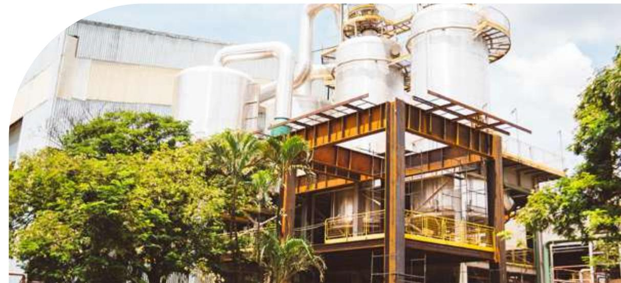
Cozedor e pré- evaporadores, e, na frente, estrutura para novos evaporadores e cozedores para a safra 24/25 (Fábrica de Açúcar)
